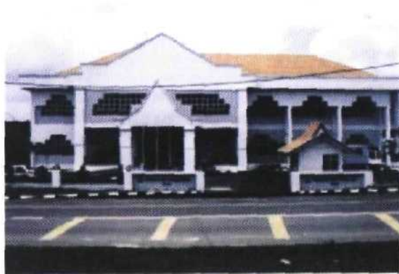
Perpustakaan Awam Cawangan Merlimau, Perbadanan Perpustakaan Awam Melaka
